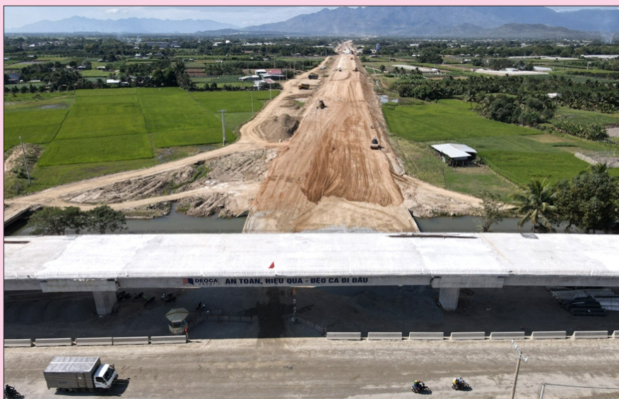
Dự án đường bộ cao tốc Bắc – Nam đoạn qua tỉnh Ninh Thuận.
